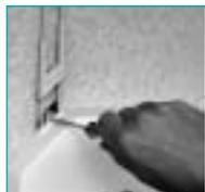
Pour ne pas déclencher la sirène intégrée (autoprotection), il faut **maintenir la centrale plaquée contre le mur pendant le vissage.**
