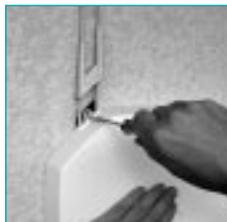
1. Utilisez le gabarit de fixation fourni pour repérer les trous de fixation.
